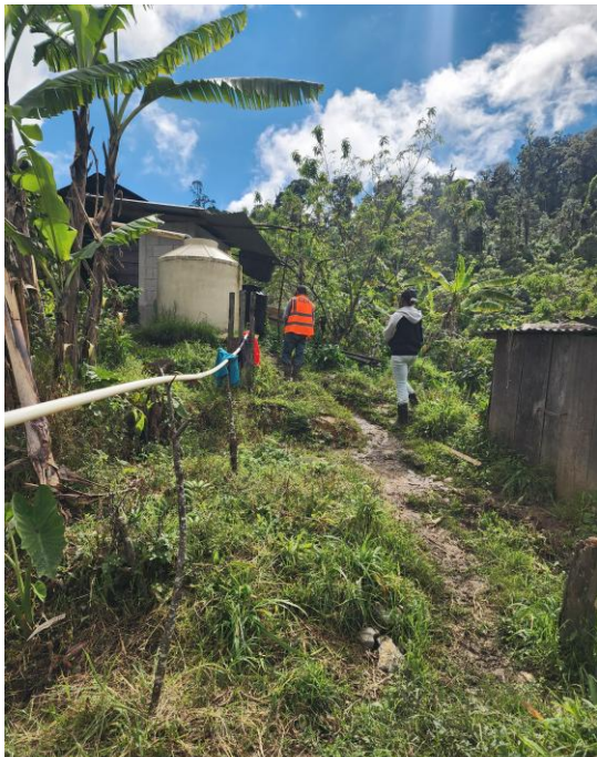
Tinaco de captación de aguas lluvias en San Pablo
